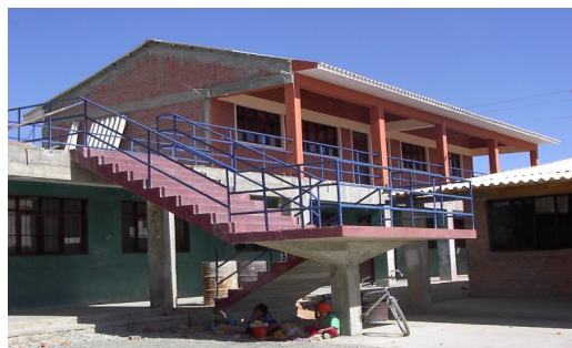
De eerste twee lokalen op de tweede verdieping.
